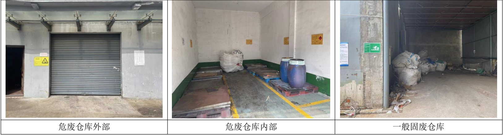
图 3-4 固废仓库现场照片
